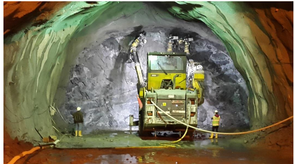
Portal Oriental Túnel 1 Santa Elena
