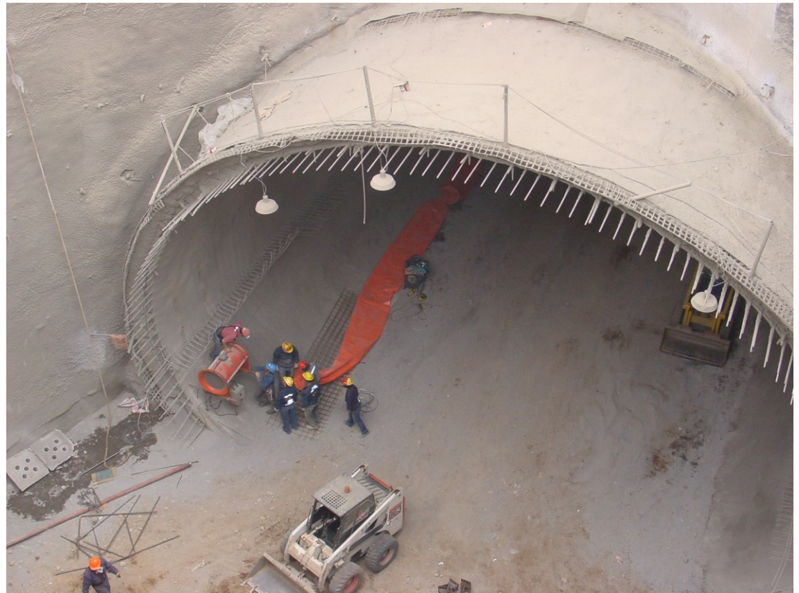
Túnel de Andenes Estación 150 m 2
