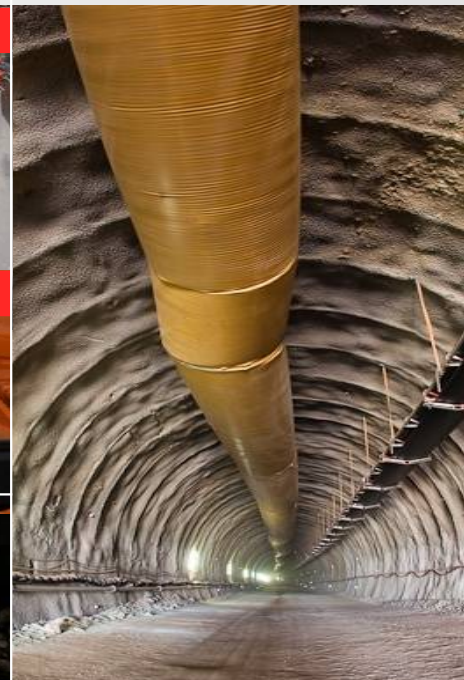
Servicios de shotcrete
