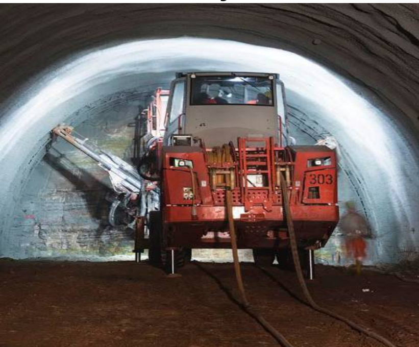
Perforación y Voladura de Roca
