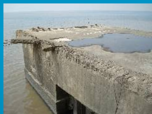
Cámara de Enlace Julio 2011
