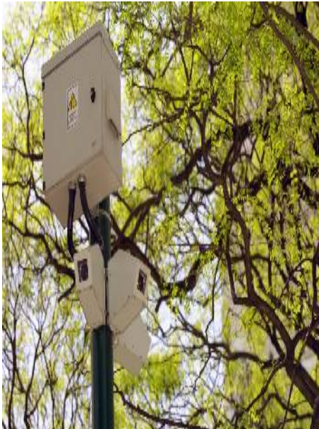
INSTALACIÓN DE CÁMARAS DE SEGURIDAD (CCTV).
